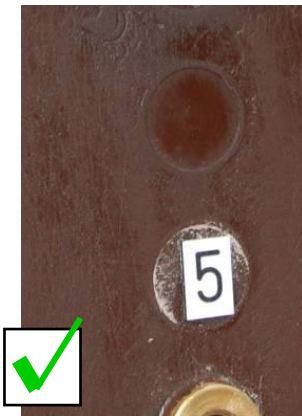
Kuva 14: Kunnossa. Pienempiä epäsäännöllisyyksiä pinnalla ja sen maalauksessa
