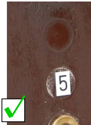
Fig. 14 : Correct. Petites irrégularités de la surface et au niveau de la couleur
