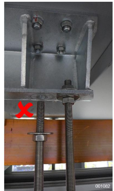
Csavarok meglazulva
